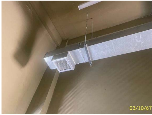
ระบบระบายอากาศห้องเครื่องสูบน้ำ
