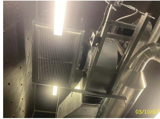
ระบบระบายอากาศห้องเครื่องไฟฟ้า
